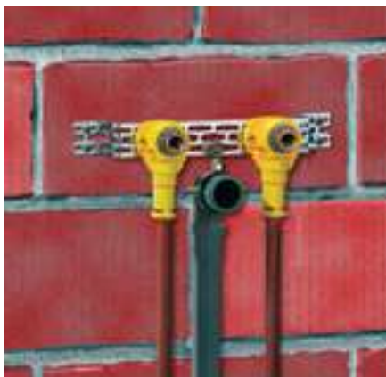
Монтаж умывальника: точный монтаж по заданным размерам
